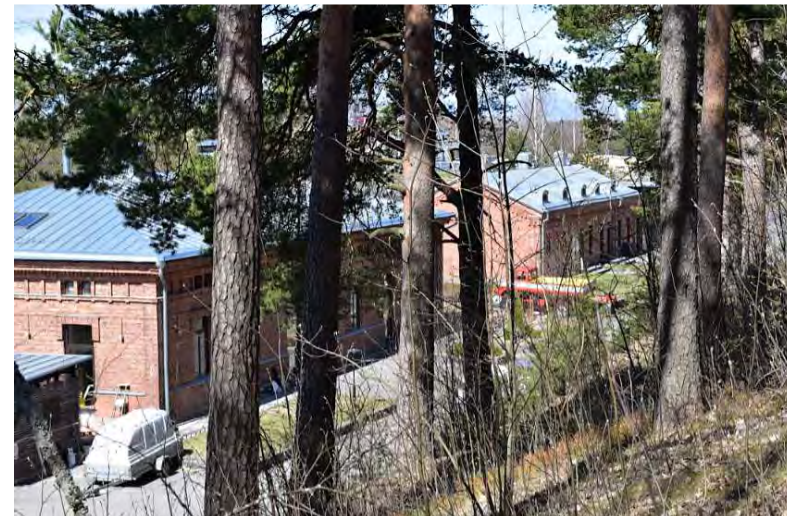
Kuva: Asuinrakennuksiksi saneeratut tiiliset talousrakennukset sijaitsevat jyrkän rinteen alapuolelle, rannan tuntumassa. Rakennus nro 56 on kuvassa taka-alalla.
