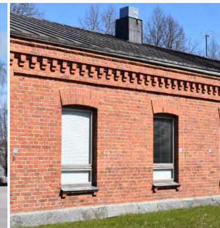
Kuva: Tavallisimpia varuskuntatoiminnan aikaisia ulkoasullisia muutoksia olivat oviaukkojen suurentaminen tai lisääminen sekä ikkunoiden uusiminen alkuperäistä yksinkertaisemmalla karmi- ja puitejaolla.
