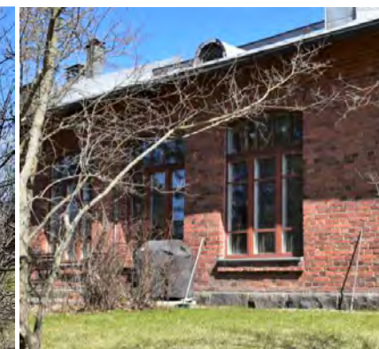
Kuva: Uudet, isot ikkunat.
