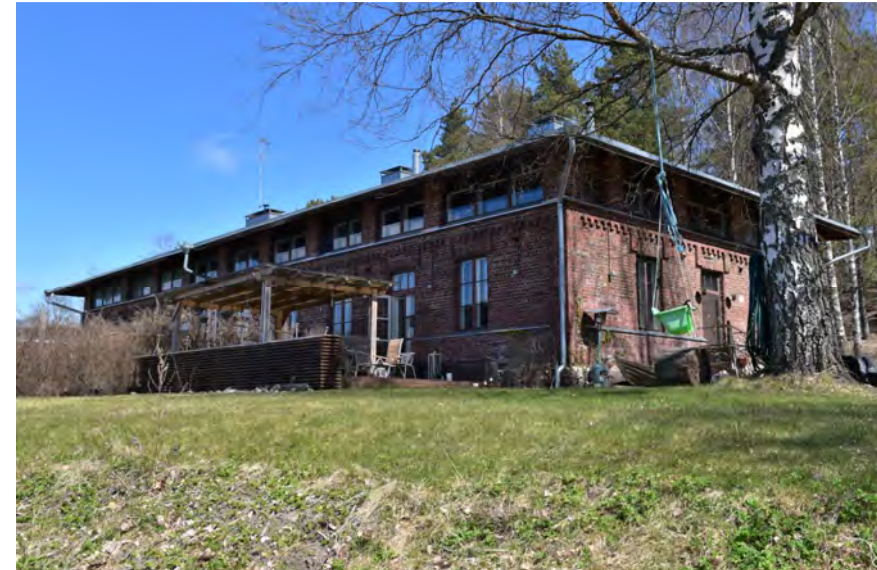
Kuva: Asuntokäytössä olevaan entiseen saunarakennukseen on lisätty ikkunoita sekä räystään alapuolelle että puhkaisemalla ikkunoiksi entiset saunan valeikkunat.
