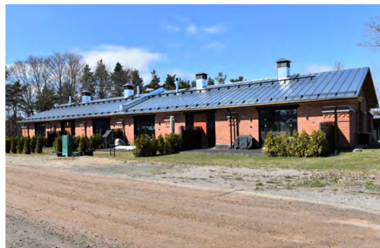
Kuva: Rakennus vuonna 2011.
