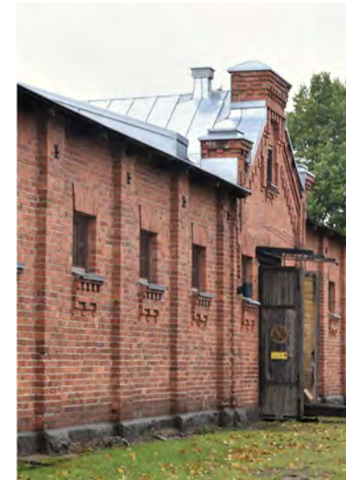
Kuva Ristipäädyn harjalla on sakara, räystäään alla puiset profiloituneet katonkannattajat.
