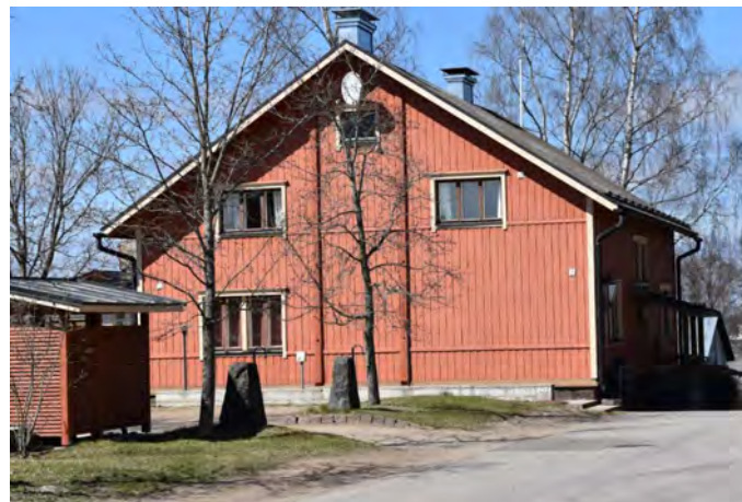
Kuva: Entinen kauramakasiini on muuttunut alueen rakennusta kaikista kokonaisvaltaisemmin. Peruskorjaus tehtiin jo kohta sotien jälkeen.
