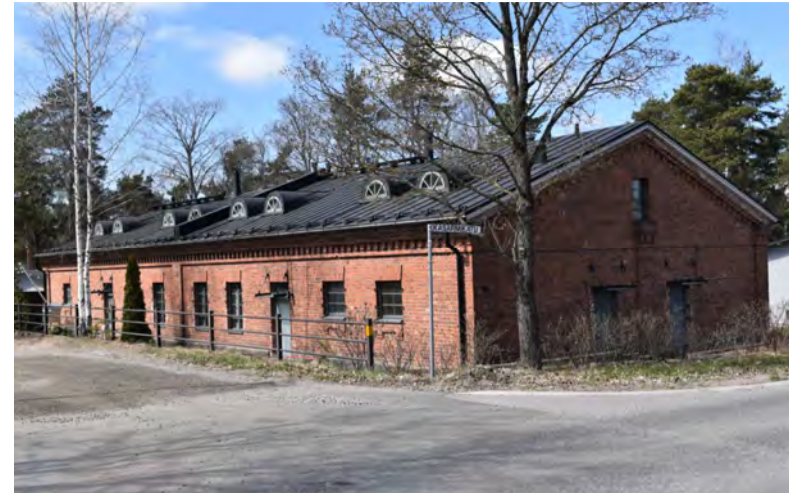
Kuva: Entisen varastohuoneen ikkunoiden yläpuolella on tukimuuraus ja alapuolella tiilireliefi. Hammaslista kulkee räystäään alla ja liseenit on sijoitettu nurkkiin ja keskiakselille.
