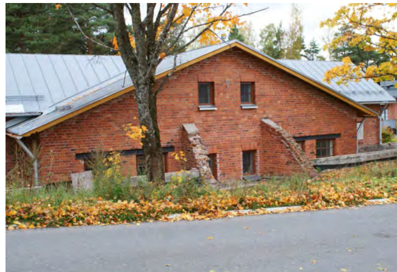
Kuva: Kellari jää vierestä kulkevan Kasarmikadun alapuolelle. Päätyseinässä tiiliset vinotuet.
