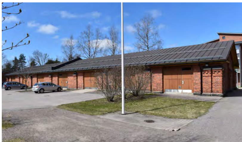
Kuva: Ainakin 1920-luvun puolivälistä lähtien on rakennuksen toisella pitkällä sivulla ollut nykyinen määrä isoja halliovia. Vanhoissa oviaukoissa on uudet puupintaiset ovet.
