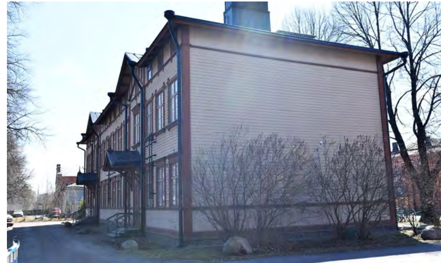
Kuva: Asuinrakennuksen Liisankadun puoleinen julkisivu. Rakennuksen päädystä on purettu mutteri-ulonne. Päätekoristeet ovat säilyneet katosten harjalla. Katto on varustettu räystäskouruin ja syöksytorvin.
