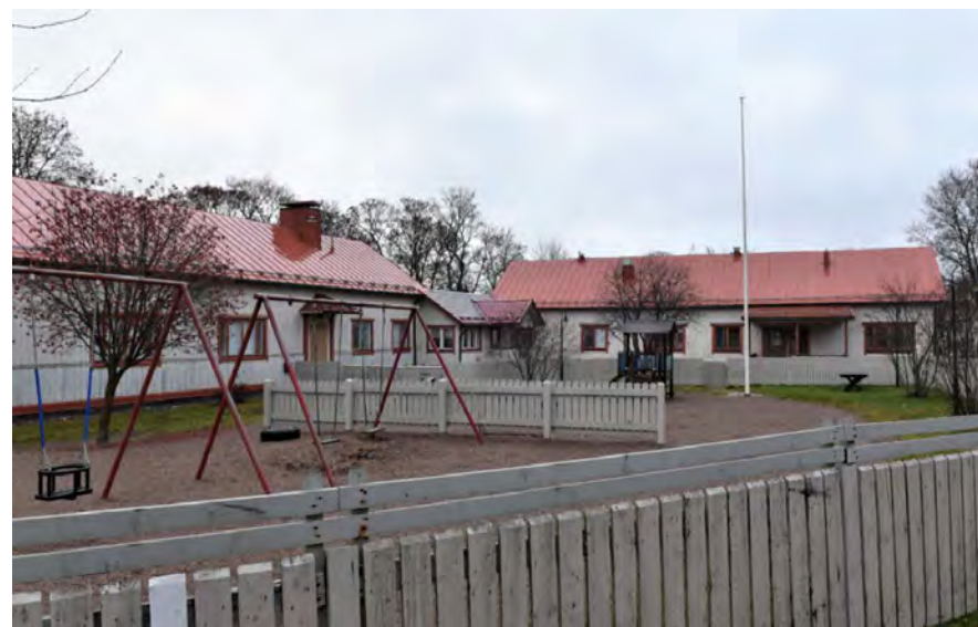
Kuva: Kuvassa on päiväkotirakennukset vuonna 2017. Aita on uusittu 2010-luvulla.
