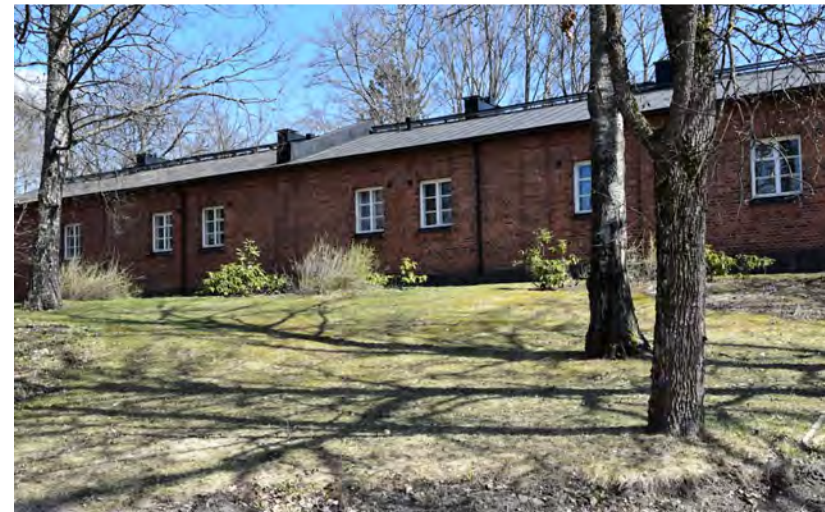
Kuva: Pitkä, kapearunkoinen rakennus sijoitettiin sen alkuperäisen käyttötarkoituksen vuoksi etäälle varuskunnan muista rakennuksista ja piha-alueista.
