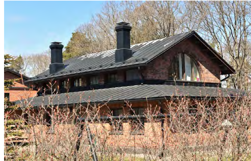
Kuva: Korjauspajan omintakeinen kokonaishahmo on säilynyt, yksityiskohdissa näkyy korjausten tuomaa kerroksellisuutta.
