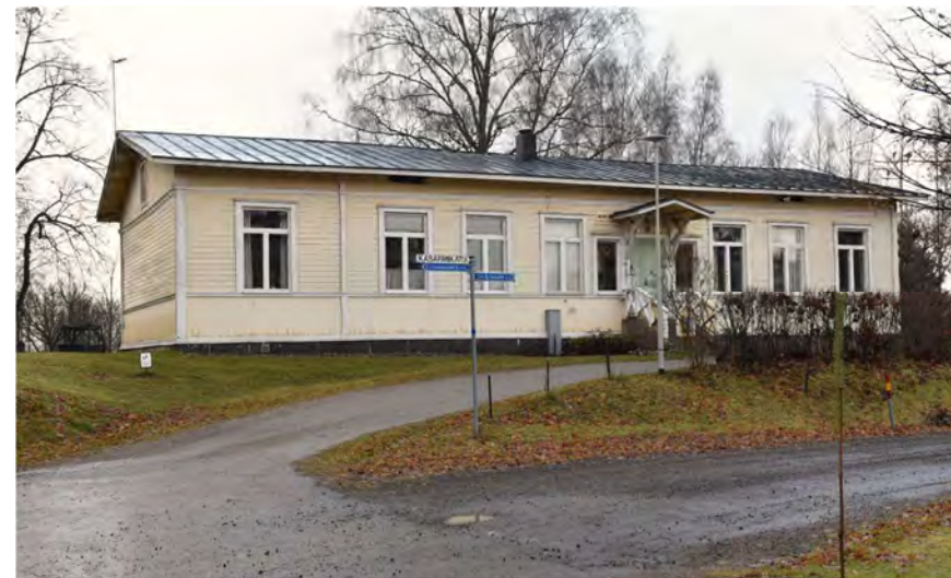
Kuva: Alkujaankin melko vaatimattoman puurakennuksen tyylipiirteet ovat hieman köyhtyneet julkisivuremonteissa.
