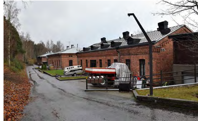
Kuva: Etualalla on entinen venäläiskauden leipomo, seuraavina Rakuunarykmentin leipomo ja sauna. Rakennuksessa nro 56 on leveä harjakaton räystäslinjaa korostava korokemuuraus ja nurkkaliseenit. Ikkuna-aukon yläreuna on kaareva.
