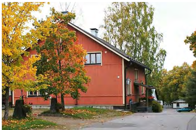
Kuva: Kadun puoleinen sisäänkäynti on tehty 1948.
