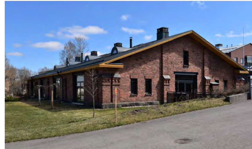
Kuva: Kahdessa varastorakennuksissa on syvä runko ja loiva katto, jonka kulmissa räystääs kääntyy kissanpenkiksi. Rakennuksen peltikate on uusittu, mutta puolipyöreät ullakkoikkunat on säilytetty. Asuntokäyttö on tuonut paljon lasipintaa tiilen rinnalle.
