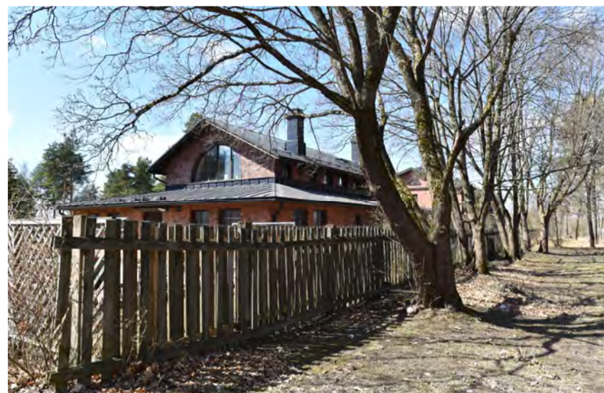
Kuva: Lounaissivun puuaita. Vanha tiilipaja on saatettu tehdä entisestä kappelista.
