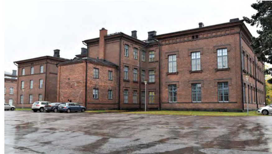
Kuva: Toimistotiloiksi peruskorjattuun kasarmirakennukseen on palautettu alkuperäisten kaltaiset ikkunat. Ulkopuitteiden väriksi on valittu harmaansininen. Katto on varustettu räystäskouruihin ja syöksytorvin.
