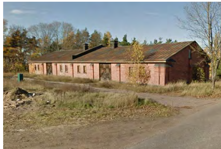
Kuva: Rakennus ennen peruskorjausta. / Google Street View 2009.
