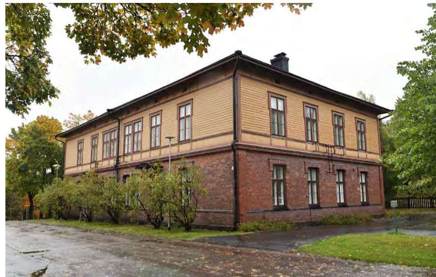
Kuva: Rakennuksen julkisivut ovat symmetriset ja vahva horisontaalisuus syntyy kerroksittain vaihtuvasta pintamateriaalista ja vaakalistoista.
