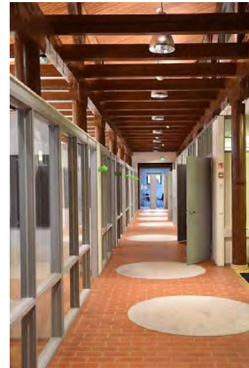
Kuva: Sisätilat on uudistettu, mutta puupilarit ja yläpohja puurakenteita on hyödynnetty sisutuksessa.
